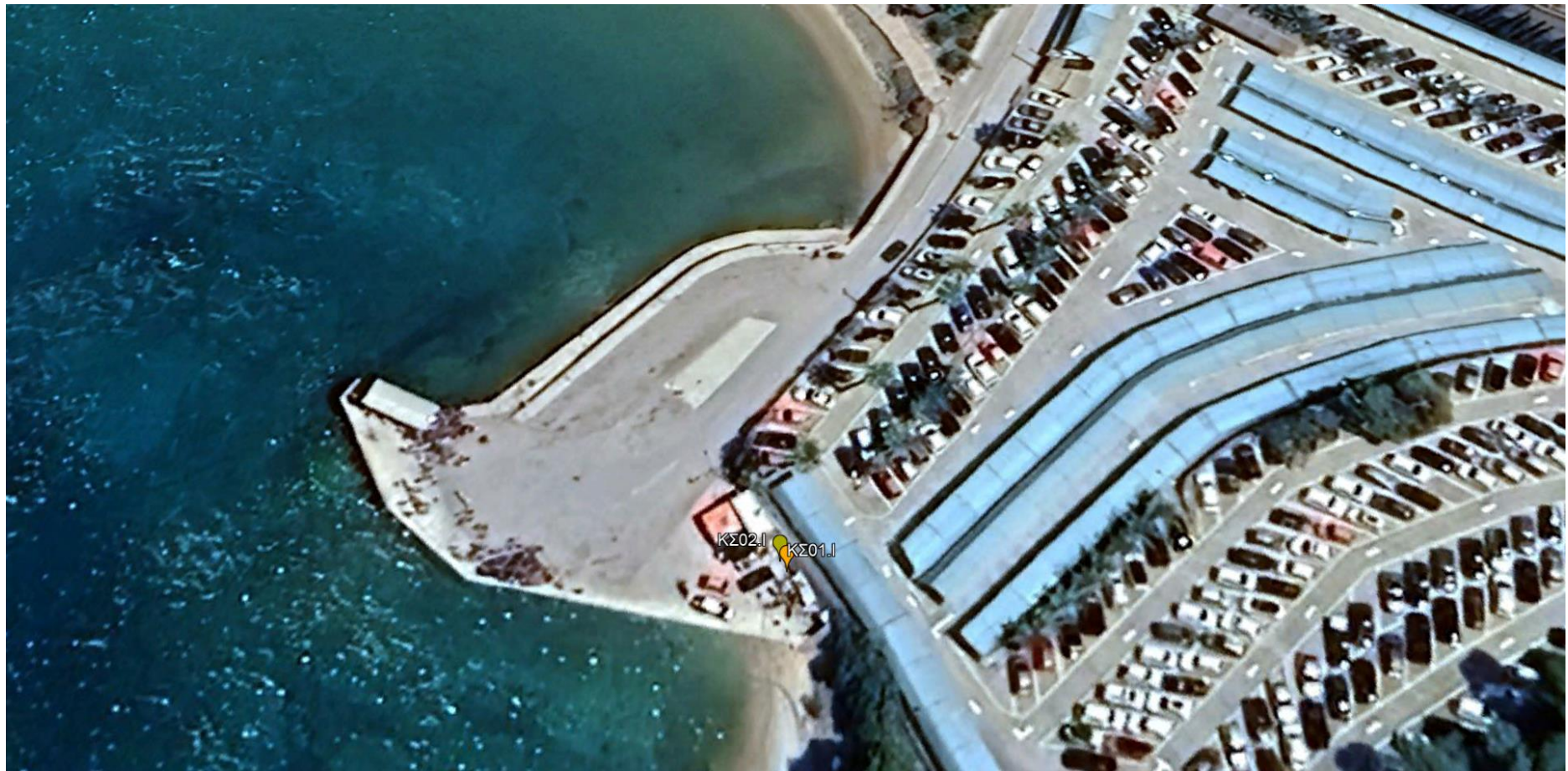
Εικόνα 24: Υφιστάμενες Θέσεις Χωροθέτησης Ευκολιών Υποδοχής Πετρελαιοειδών Αποβλήτων Πλοίων στο Λιμένα Κόστα
