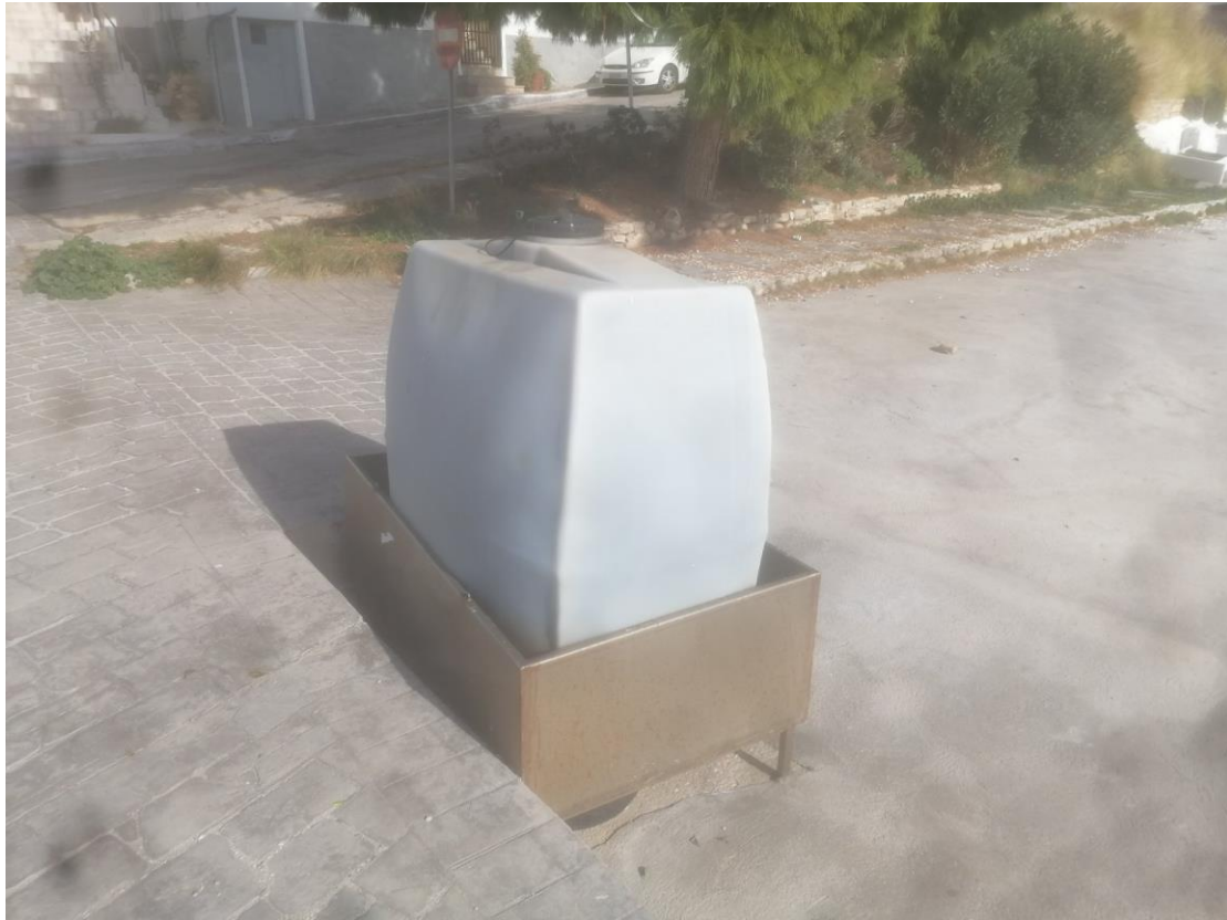
Εικόνα 9: Πλαστική Δεξαμενή Χωρητικότητας 600lt για Συλλογή Πετρελαϊκών Καταλοίπων & Απόβλητων Λιπαντικών Ελαίων (νότιος λιμένας Ερμιόνης)
